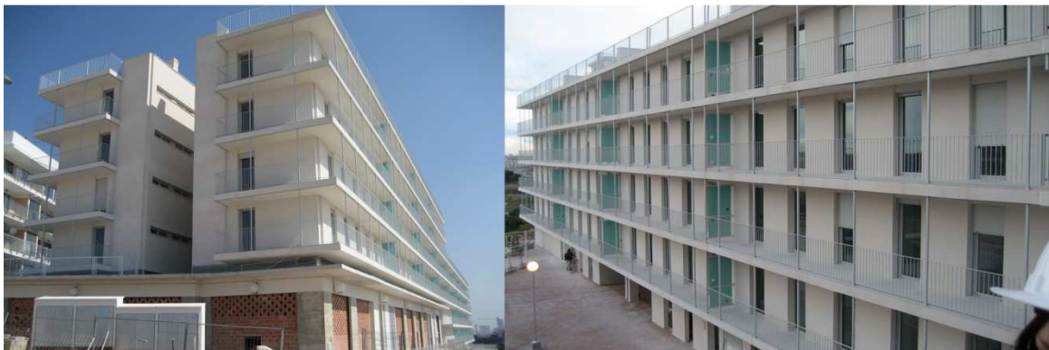
DIRECCIÓN DE OBRA. EDIFICIO DE 72 VPO EN MAS DEL ROSARI (PATERNA, VALENCIA) 2007-2009
