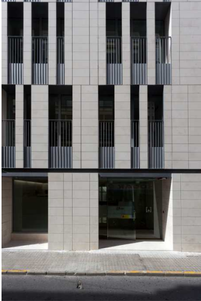
CENTRO SERVEF DE EMPLEO ELDA (ALICANTE). PROYECTO Y DIRECCIÓN DE OBRA 2009-2013
