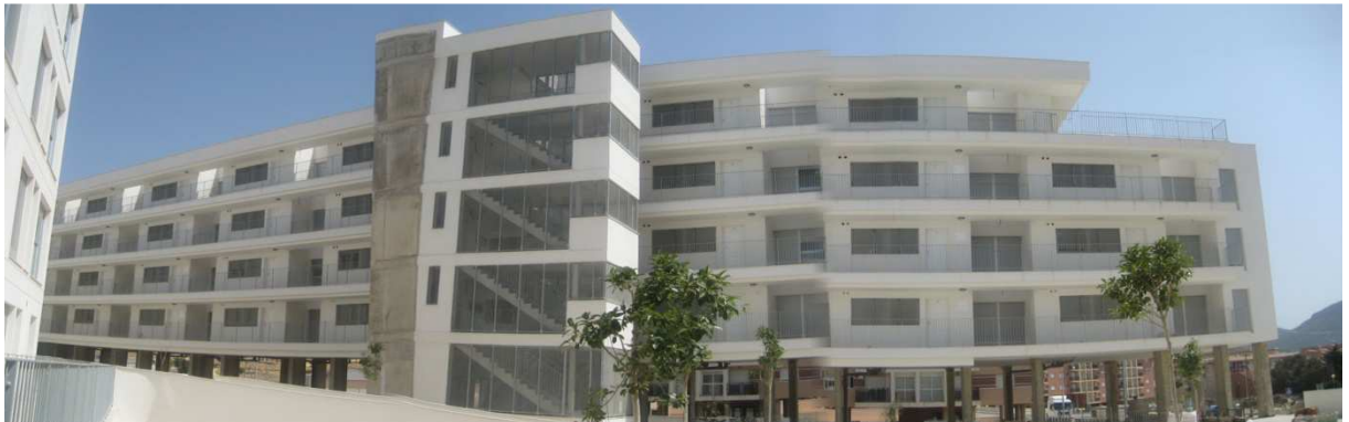
81 VPO EN CARTAGENA (MURCIA)-DIRECCION DE OBRA 2008-2009
